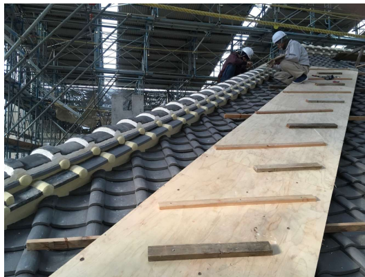
【隅棟瓦漆喰塗り】
