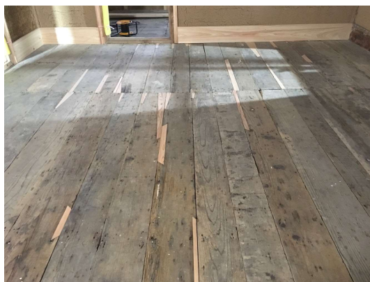
【内部床板張り】
