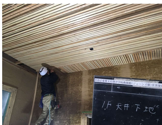
【内部天井下地】
