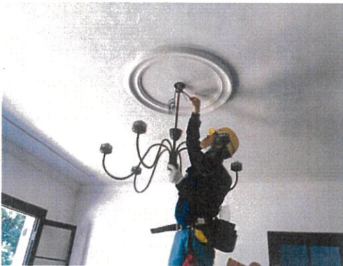
【照明器具取付】
