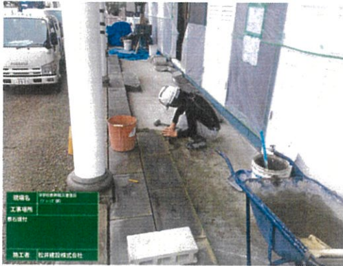
【1階ベランダ敷石据付】
