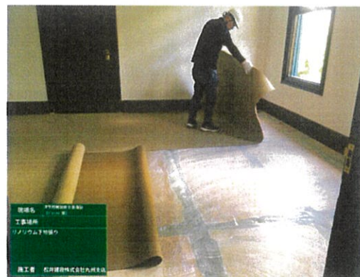
【床仕上げ工事】
